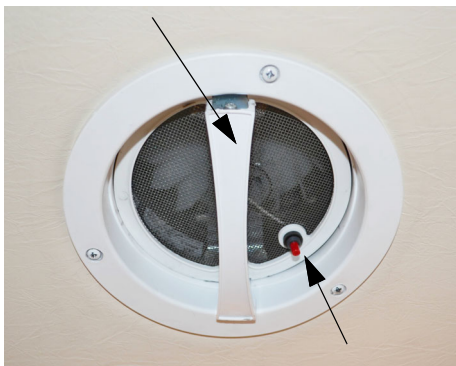
Fan Power Switch
